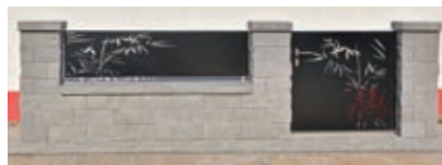
Einbau als Zaunanlage
